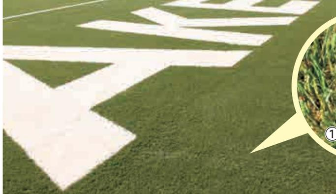
ロングパイル人工芝の材料には、超耐久ポリエチレンを使用し、温度上昇の抑制や選手のケガ防止のためにゴムチップを充填しています(写真①)。
