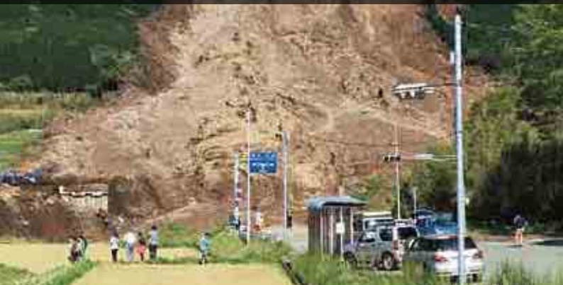
阿蘇大橋崩落現場
