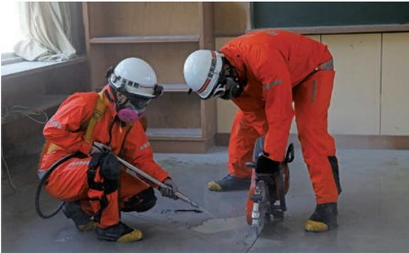
▲エンジンカッターを用いてコンクリート製の床を切断する隊員
