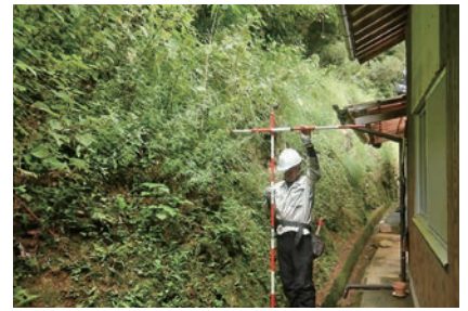
▲住宅裏の急傾斜地地形等を確認します
