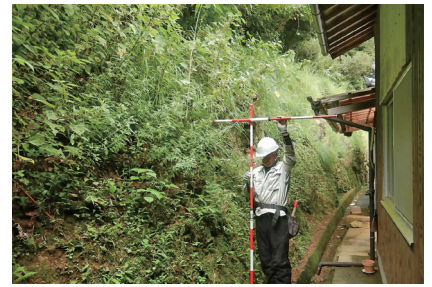
▲住宅裏の急傾斜地形等を確認します
