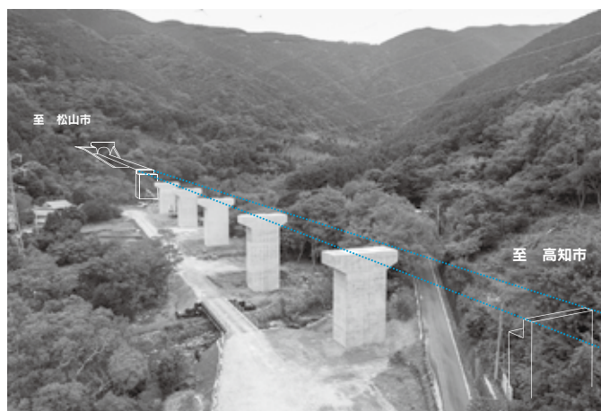
津島道路柏川橋(仮称)工事状況(愛南町柏地区)
