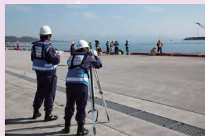
【港湾施設被害調査】
