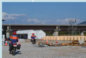
【車両による被災状況調査】
